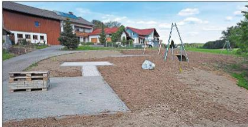
Hier, entlang der Prinzstraße, entsteht gerade der neue Zimmerner Kinderspielplatz.
