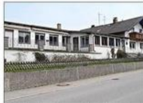
Das ehemalige Gasthaus Pertschy in Reut wurde von der Gemeinde erworben und soll abgerissen werden.
