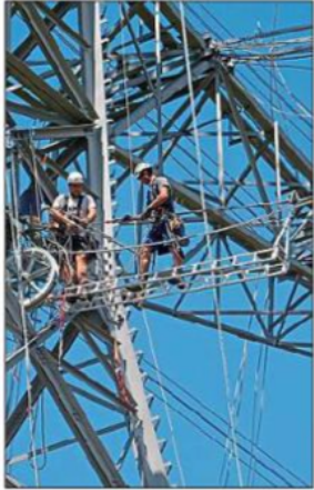
Die Masten werden im Inntal seit Monaten gebaut. – Foto: red
