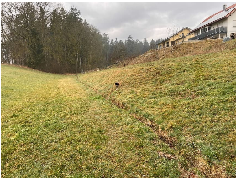
Graben 1: Ausleitung bestehendes RRB „WA Noppling“
