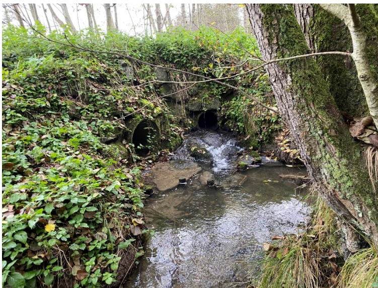
Graben 1: links Einleitung DN 600 in Seitenarm des Nopplinger Baches
