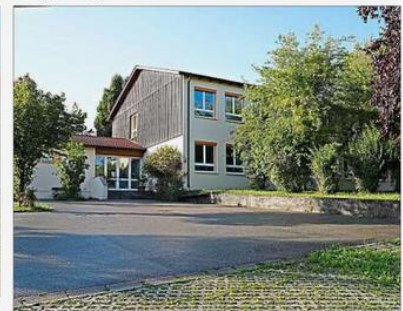
So sieht der Eingangsbereich an der Grundschule Reut aktuell aus.
