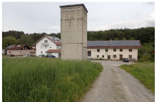
Blick über die Zufahrt nach Wagenöd zur Dorfstraße. Das Transformatorhaus wird abgerissen und durch einen Neubau an anderer Stelle errichtet. (07.05.2024)
