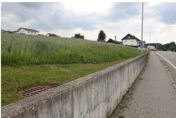
Blick nach Norden entlang der Ostgrenze des Planungsgebiets. Rechts der Gehweg entlang der Kreisstraße PAN 25 (Hauptstraße), links der schmale Grünstreifen über dem Schmutzwasserkanal zwischen Gehweg und Acker (16.06.2022)
