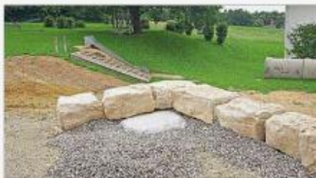
Der Außenbereich des Kindergartens (im Vordergrund) dient als Raum für ruhige Beschäftigungen und wird klar abgetrennt vom Pausen-Garten der Grundschule. Hier sind bis September noch einige gestalterische Arbeiten notwendig.
