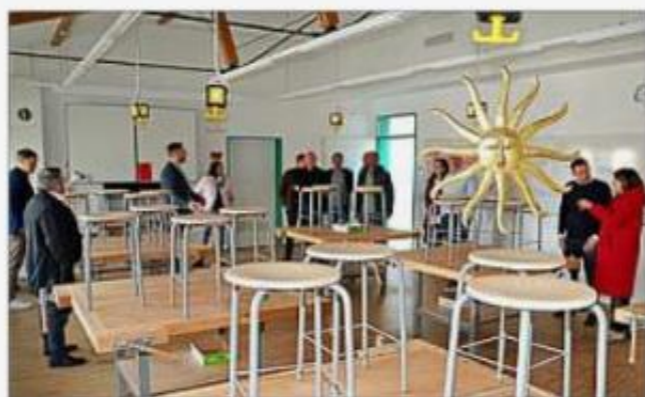
Die Vertreter des Schulverbands bei der Besichtigung der Baustelle: Hier im neuen Werkraum.
