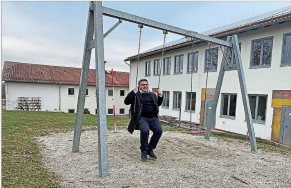
Die Grundschule (rechts) in Walburgskirchen wird saniert, der Kindergarten wird dann mit einer zusätzlichen Gruppe, die weitere 25 Plätze bietet, in das Gebäude einziehen. Das jetzt für den Kindergarten genutzte Haus (hinten) könnte dann für die Ganztagsbetreuung infrage kommen.
