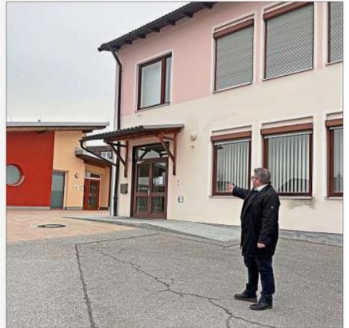
Das alte Rathaus in der Wallnerstraße soll saniert und dann Platz für eine weitere Krippengruppe bieten. Ein Durchgang zwischen Krippe und Bestandsgebäude soll gebaut werden.
