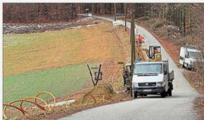
Bereits begonnen hat vor drei Wochen der Breitbandausbau für dieses Jahr. 70 weiße Flecken müssen noch weg. Reut, eine der einödrichsten Gemeinden im Landkreis, ist damit aber trotzdem vorn dabei.
