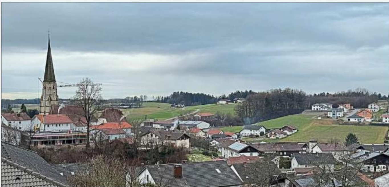
Zwei wichtige Projekte auf einem Blick: Links vor der Taubenbacher Kirche der Umbau des Kindergartens und rechts wird die Wiese mitten im Baugebiet Mittertaubenbach als Baugebiet erschlossen. – Fotos: Brodschelm
