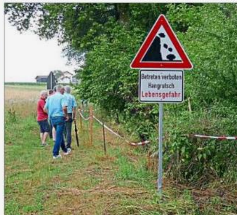
Am Kirchgraben in Walburgskirchen gab es einen Hangrutsch. Hier sollen durch die Anwohner notdürftige Reparaturmaßnahmen durchgeführt werden. Die Benutzung des Weges erfolgt weiterhin auf eigene Gefahr. – Fotos: Gilg
