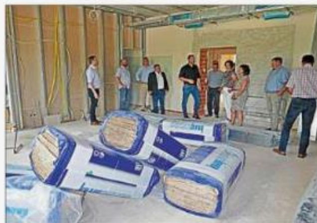
Hier soll das neue Lehrerzimmer entstehen. Das Material zur Dämmung der Wände liegt schon bereit.
