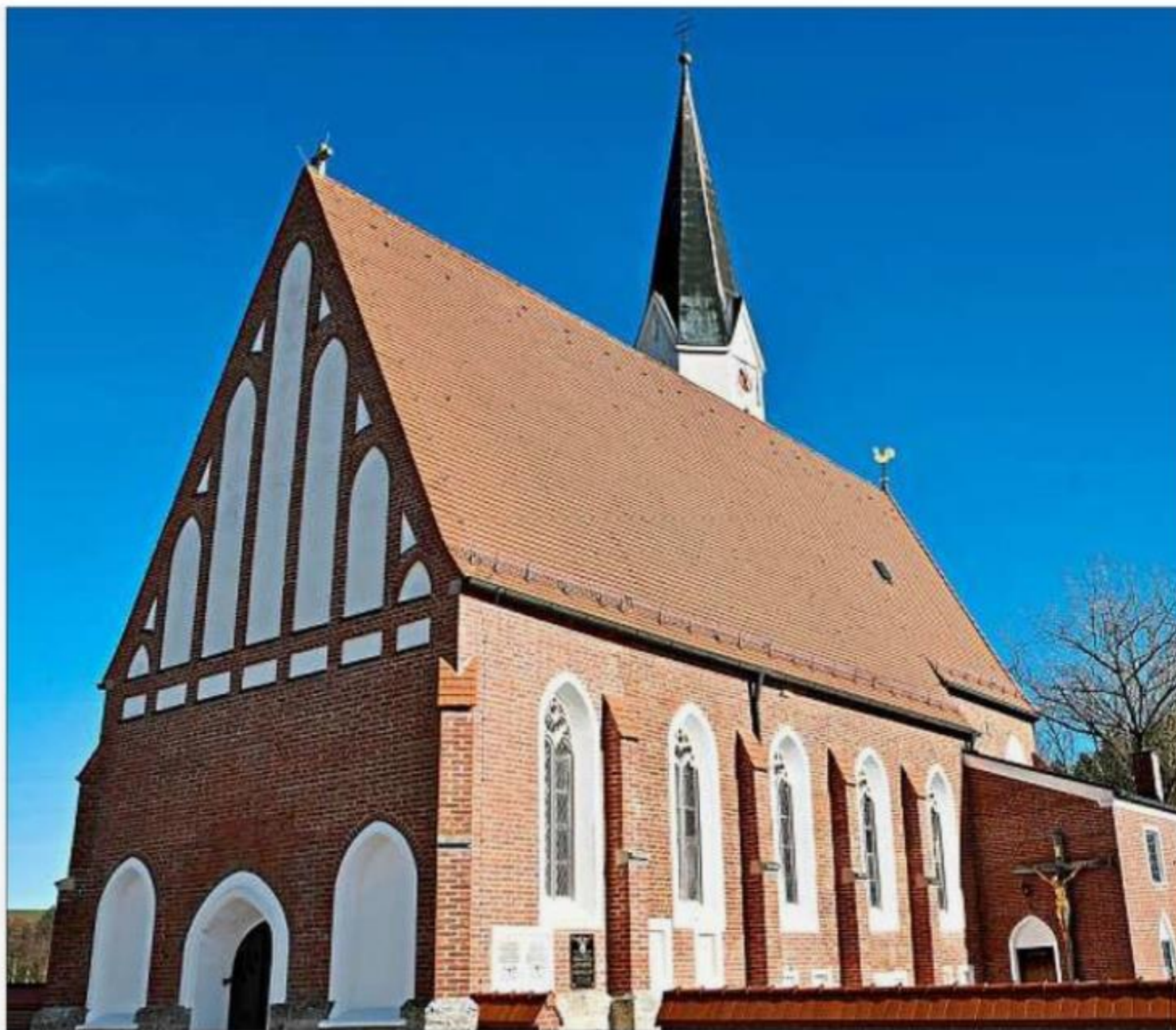
Das Dach der Nopplinger Kirche könnte bald eine PV-Anlage bekommen. Der Gemeinderat stimmte nach kurzer Diskussion über Ästhetik versus Klimaschutz zu. – Foto: Archiv PNP
