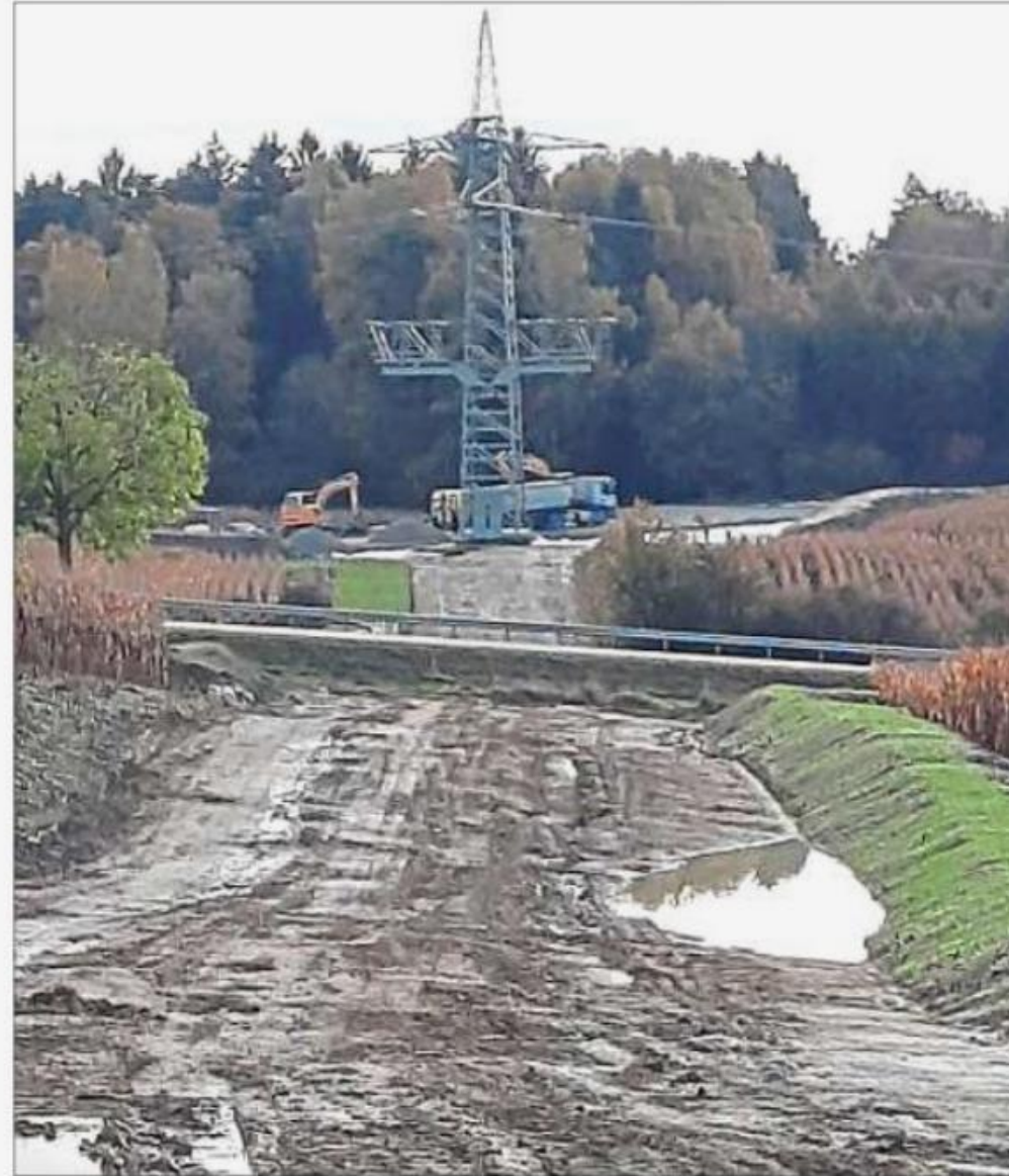
Als „Braunes Band“ zieht sich derzeit die Baustelle für die 110-kV-Leitung durch den nördlichen Bereich der Gemeinde Reut. Dies ist die größte Baustelle, die hier jemals abgewickelt wurde – Foto: Friedlmeier
