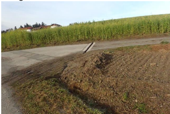
Die Abzweigung der Kiesstraße von der Bgm.-Alfranseder-Straße
